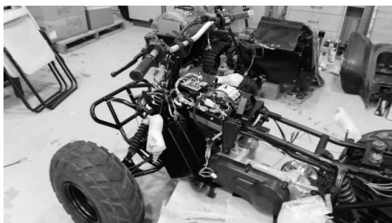
写真2. バッテリー、ドライバ、制御機器取付
