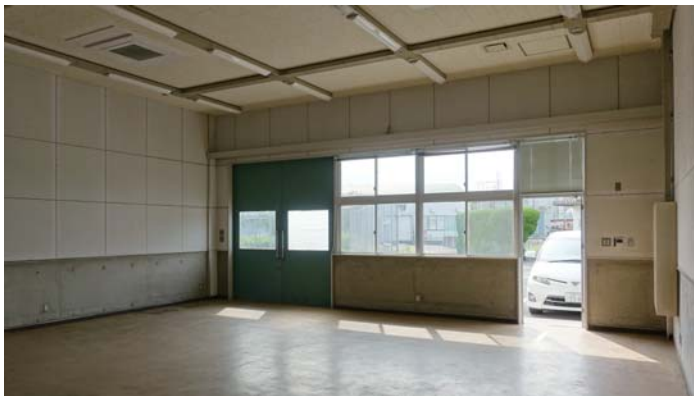
出入口（搬入口）側
