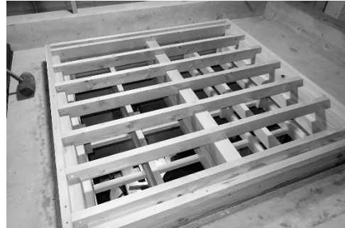
写真 1. 開口部に施工した床（床板を外した状態）
