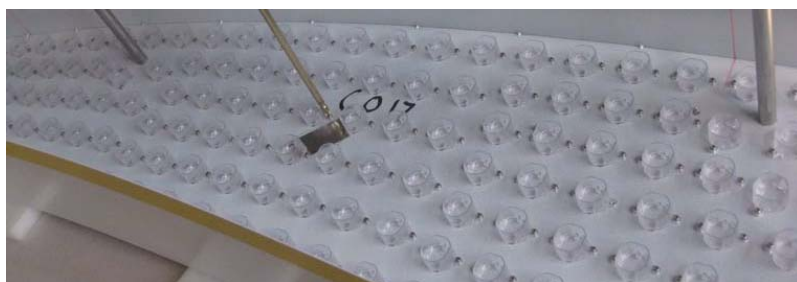
図3 看板ベースへのケース固定作業
