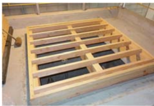
図1 開口部に施工中の試験体
