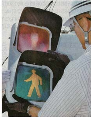
LED電球に交換される歩行者用信号機—徳島市北沖洲3
