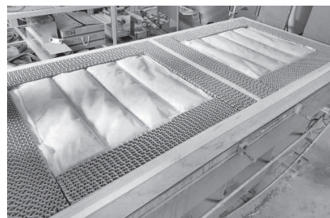
図 4 表面材を貼る前のパネル内部(パネル 7)
