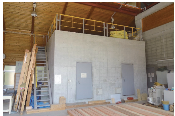
図 1 RC 壁式構造の音響測定室
