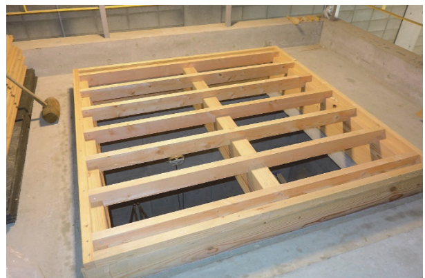
図 2 床に設けられた開口部に施工中の試験体
