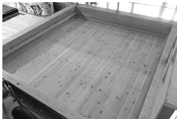
図2 2階の床に乾式二重床を施工した様子
