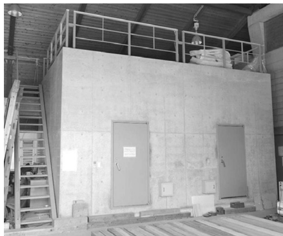
図1 木材利用創造センターの音響測定施設
