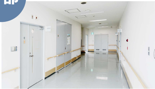
3F 廊下：左手に分析測定室
