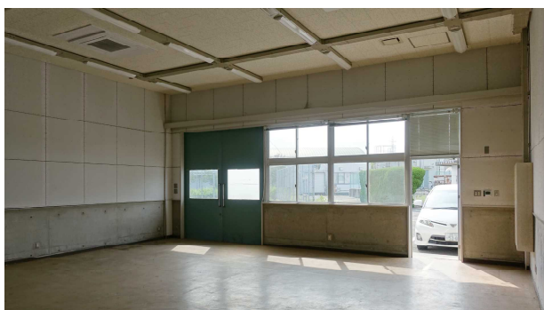
出入口（搬入口）側
